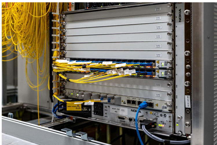
Een Delta XGS-PON OLT, eerst 1 op 2 en daarna 1 op 32 gesplitst, dus 64 aansluitingen per vezel (theoretisch max. is 128)!
